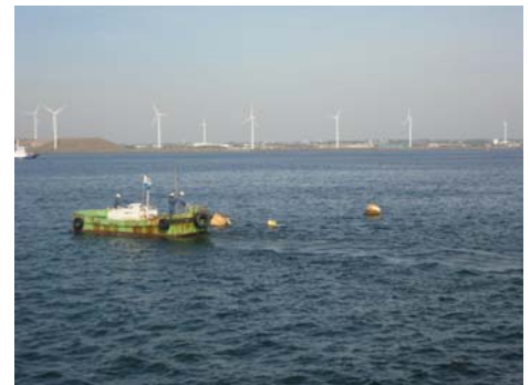
ワイヤー取り付け作業（シンカーブイ）
