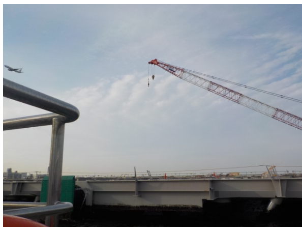
← 国際コンテナターミナル整備事業（Y2）整備状況（上部工）
