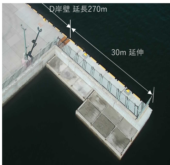
延伸部 30mの施工状況
