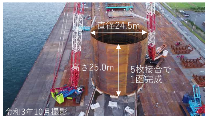
鋼板セル製作・組立状況
