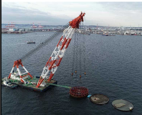
鋼板セル据付状況
