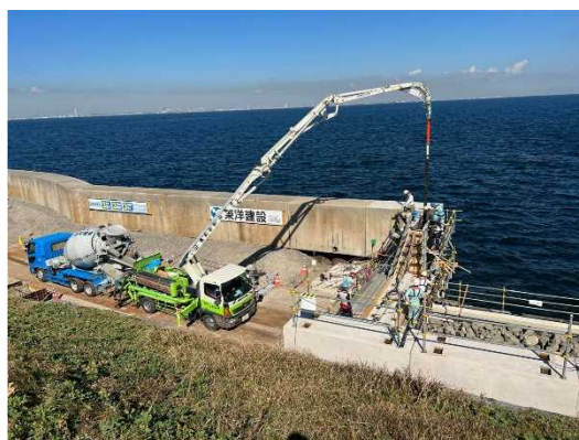
東京湾中央航路北側護岸 コンクリート打設
