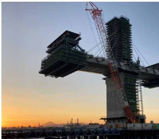
川崎港臨港道路 主橋梁上部 (MP2)
