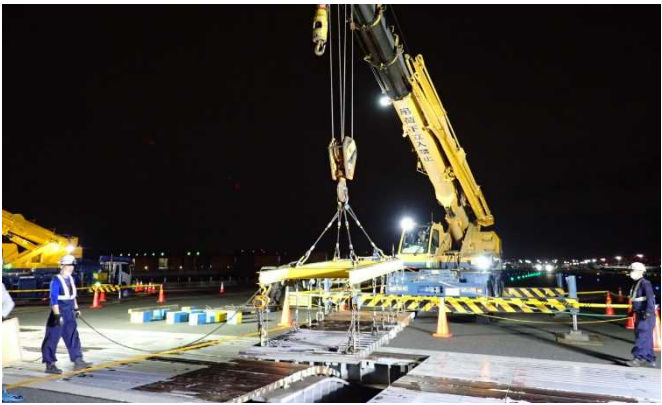
東京国際空港D滑走路 伸縮装置点検
