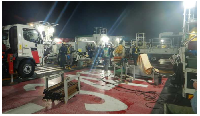
東京国際空港A滑走路南側取付誘導路 地盤改良
