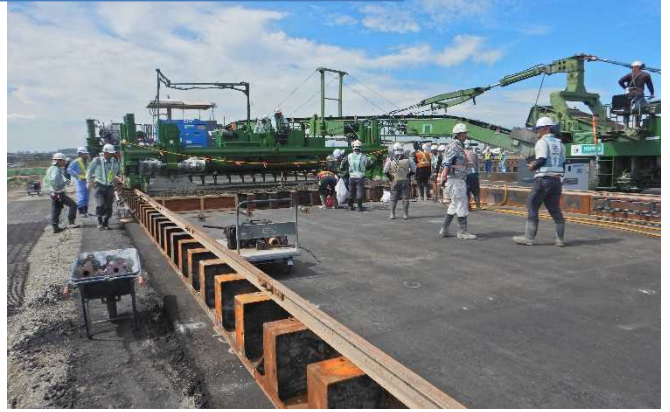
東京国際空港旧整備地区エプロン 舗装
