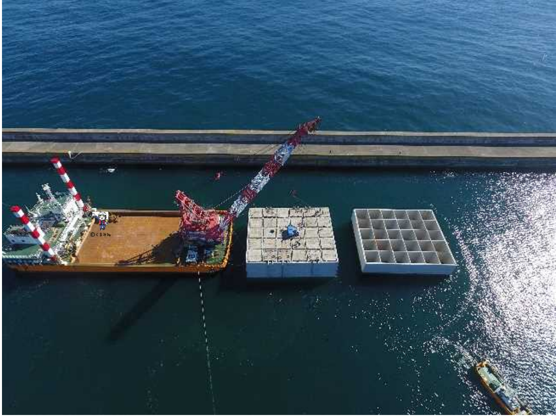
常陸那珂港区外港地区東防波堤 ケーソン仮置き
