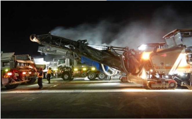
東京国際空港B滑走路 舗装改良
