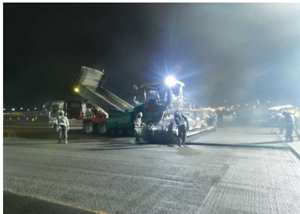
施工状況(舗装工:K誘導路)
