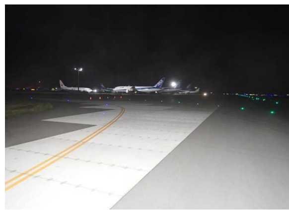
完成(舗装拡幅後:J2誘導路)
