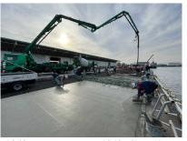
舗装工(コンクリート舗装)施工状況
