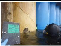
防食工(ペトロラタム被覆)施工状況
