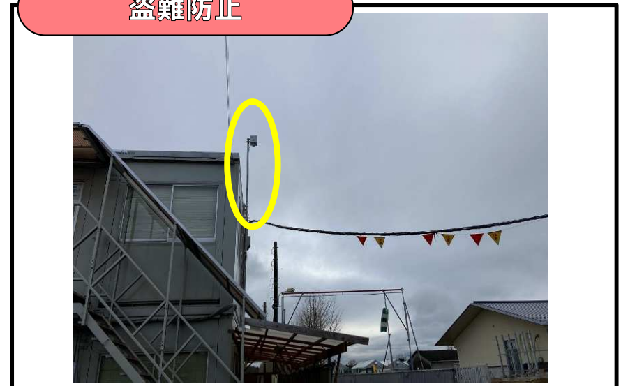
現場内での監視カメラの設置
