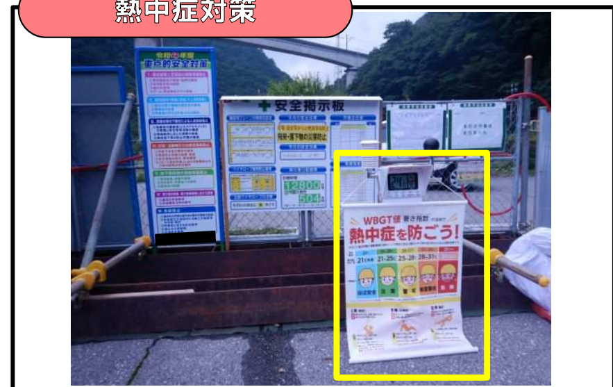
安全掲示板へWBGT(暑さ指数)測定機を設置
