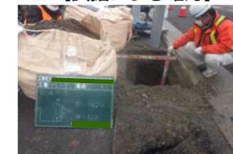
【試掘による確認】
