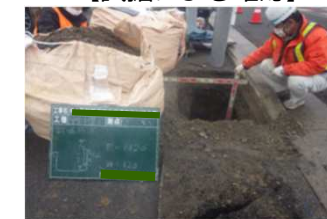
【試掘による確認】
