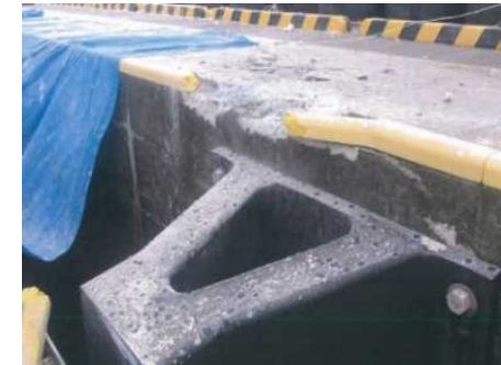
上部工・縁金物 2.0m損傷
