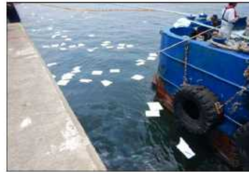
オイルフェンスの展張・吸着マットによる流出油の回収
