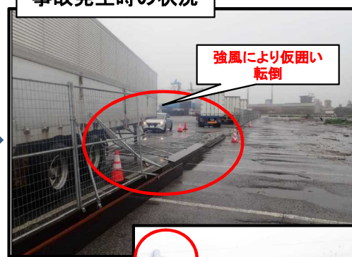
事故発生時の状況
