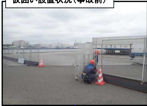
仮囲い設置状況(事故前)
