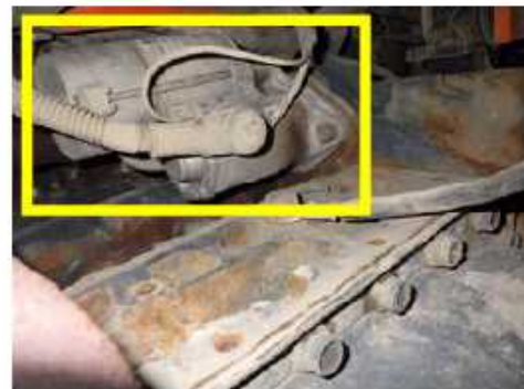
故障部位 (セルモーター)
