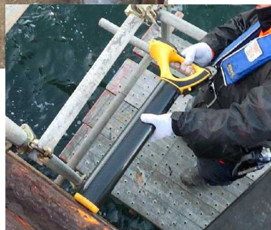
ケーブルロッカー使用状況
