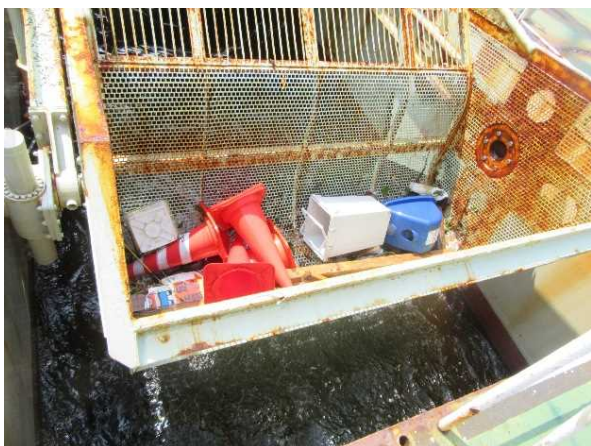
スキッパーによる回収作業
